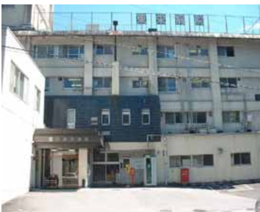
本院正面工事前
