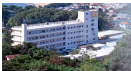
共立湊病院・外観
